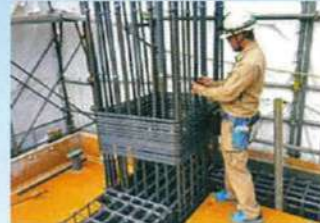
【超音波探傷検査】
